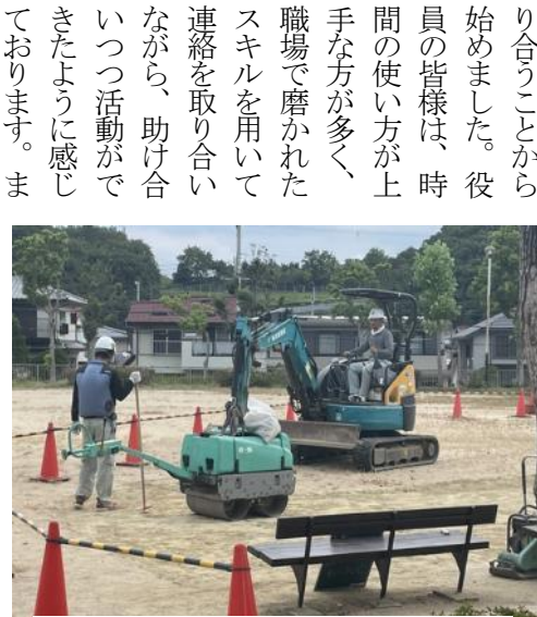
北公園整備工事 令和4年8月撮影
